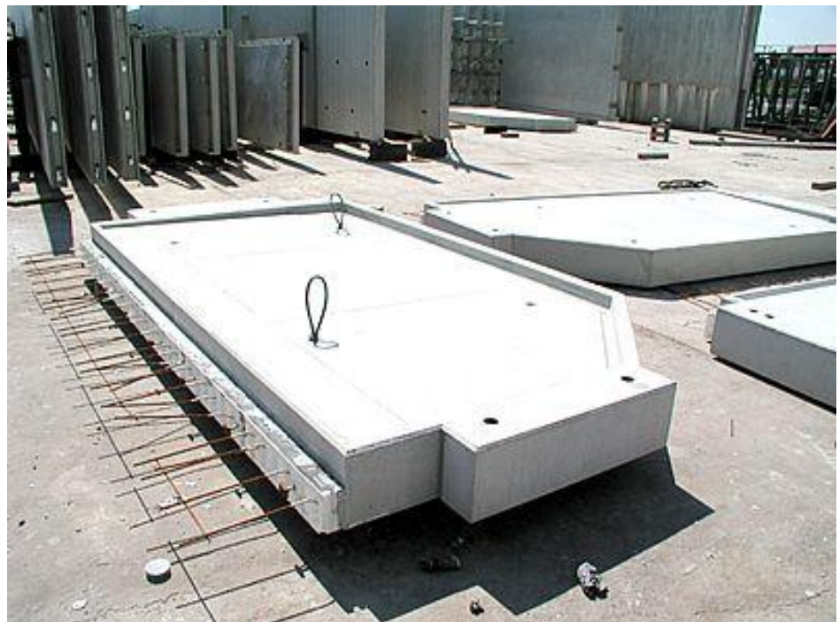
Balkonplatten mit Isokorb anschluss
