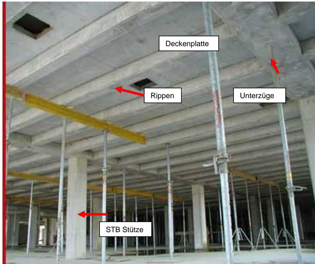
Rippendecke in einem Stahlbetonskelettbau
