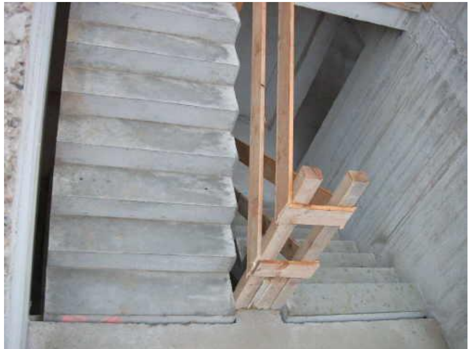
Sonstige Stahlbetonfertigteile - in Verbindung mit Stahlbetonfertigteilen.
